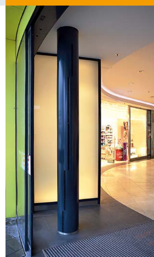
Wie das Beispiel Eingangsbereich-Einkaufszentrum zeigt, können Luftschottanlagen elegant dem Design angepasst werden.
